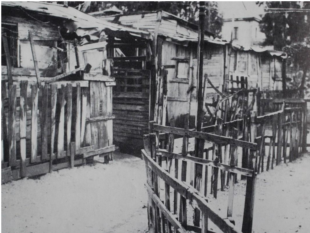
Figura 2 - Baraccopoli a Messina dopo il terremoto del 1908
