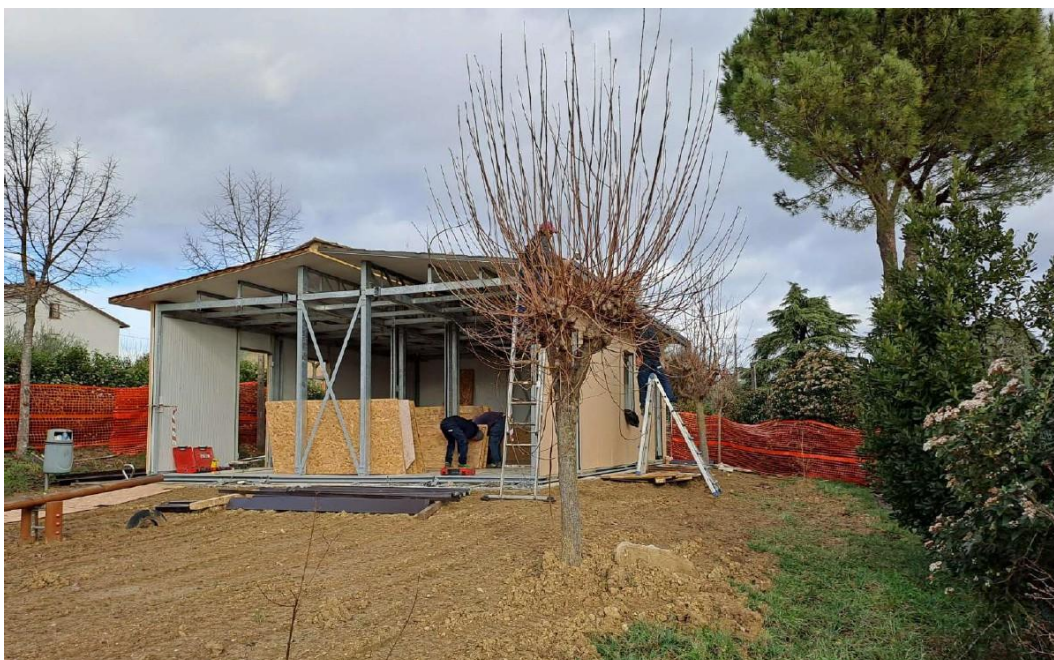
Figura 12 - SAE in fase di rimontaggio nel Comune di Fratta Todina ( PG)
