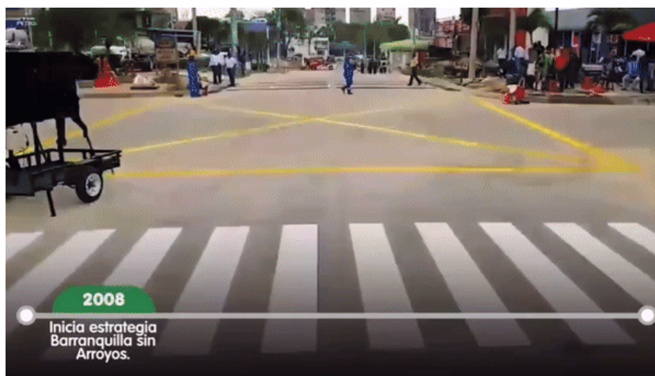
Figura 2 — Costruzione di canali sotterranei per l'acqua piovale a Barranquilla (Alcaldía de Barranquilla, 2022).
